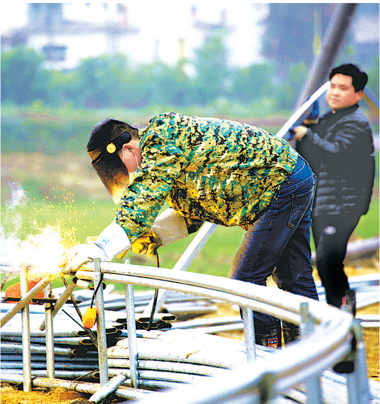
3月18日,在大余县樟斗镇樟斗村高标准农田建设项目施工现场,工人正在焊接蔬菜大棚钢架。连日来,该县在抓好疫情防控的同时,精准施策,加强与施工企业沟通,提供全方位服务,推进高标准农田建设项目复工复产,全力保障春耕生产。
