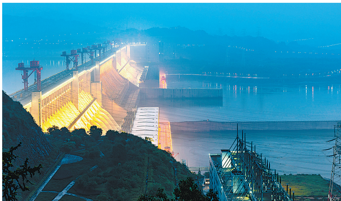
6月8日拍摄的三峡大坝泄洪闸夜景。6月8日17时,三峡水库水位消落至144.99米,提前两天完成消落任务。三峡水库本轮消落自2019年12月开始,水位自正常蓄水位175米左右消落至汛限水位145米,共消落水位约30米,腾出防洪库容221.5亿立方米,为迎战长江流域可能发生的洪水提供安全保障。新华社发
