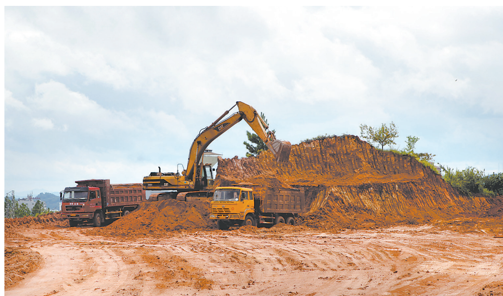
在定南县中油联合能源成品油库建设项目施工现场,挖掘机在平整土地。
