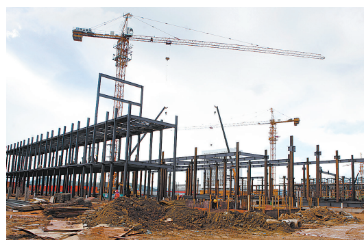
在江西联茂电子科技有限公司玻璃纤维半固化胶片及覆铜板生产项目(二期)施工现场,工人在有序吊装钢梁。
