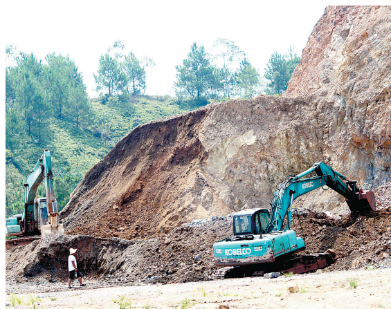
在江西华加斯新型保温材料生产项目现场,工人在开挖土方。
