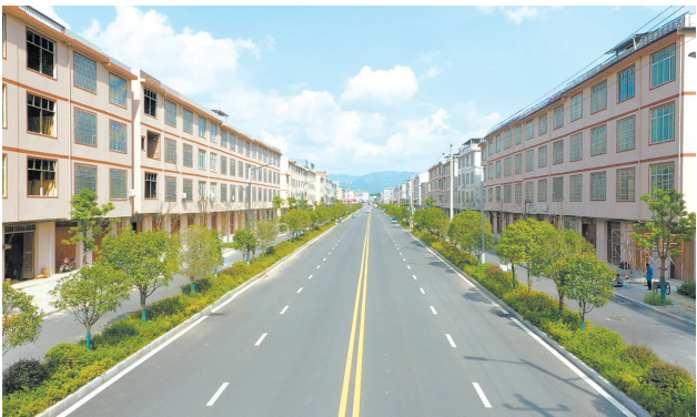
圩镇旧貌换新颜。图为宽阔的莲丰大道。
