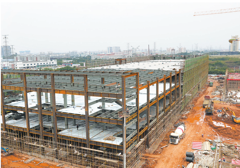
同兴达三期项目建设现场。
