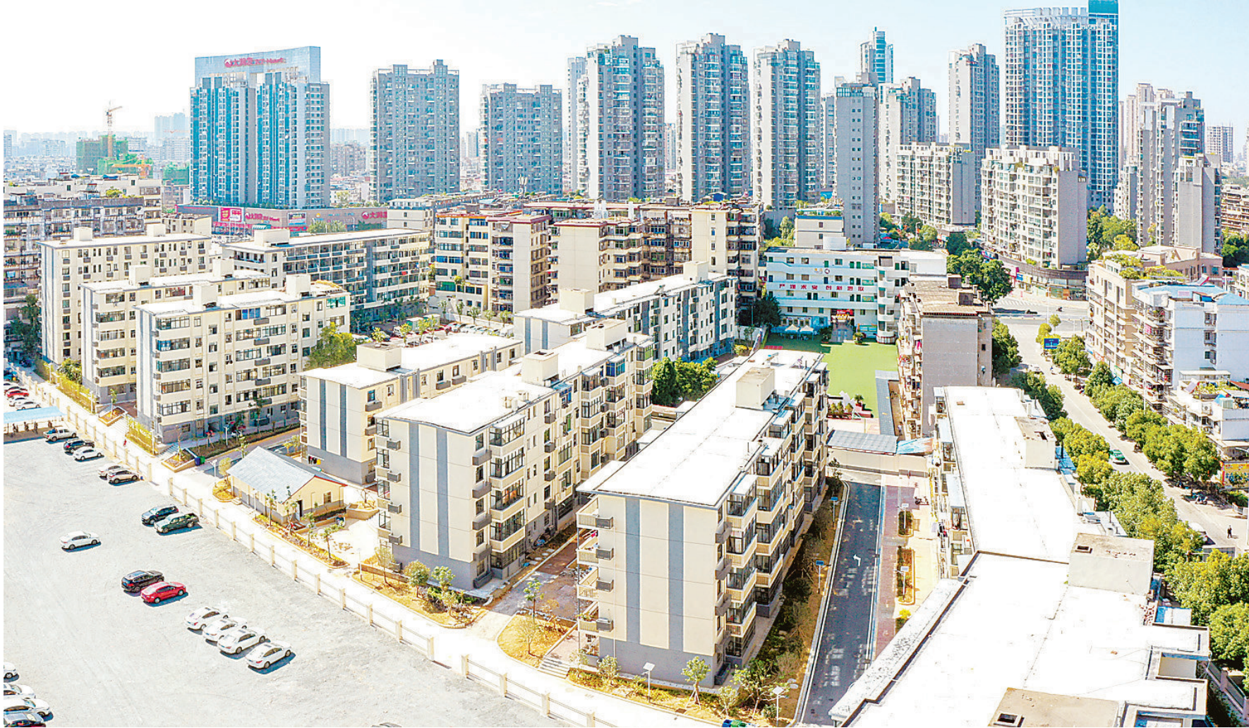
改造后的西桥路五号老旧小区。
