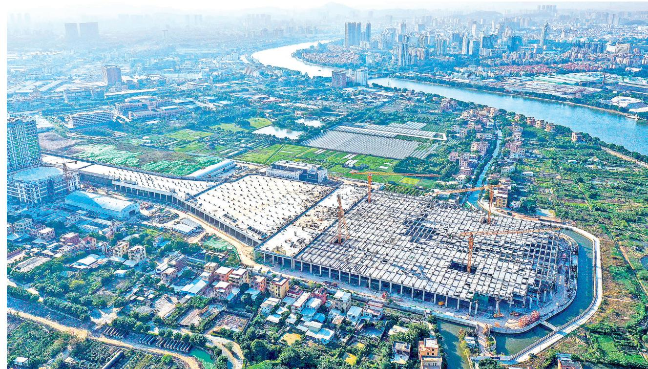
广州市地铁18号线停车场形似一把巨型吉他,横卧在珠江之畔(11月9日摄,无人机照片)。日前,由中铁十一局承建的广州市地铁18号线停车场封顶在即。该停车场占地约21万平方米,形似一把巨型吉他,主要承担地铁车辆的停放、日常保养、列检及周月检任务。地铁18号连接广州市中心城区与南沙自贸区,设计最高时速160公里。新华社记者刘大伟 摄
