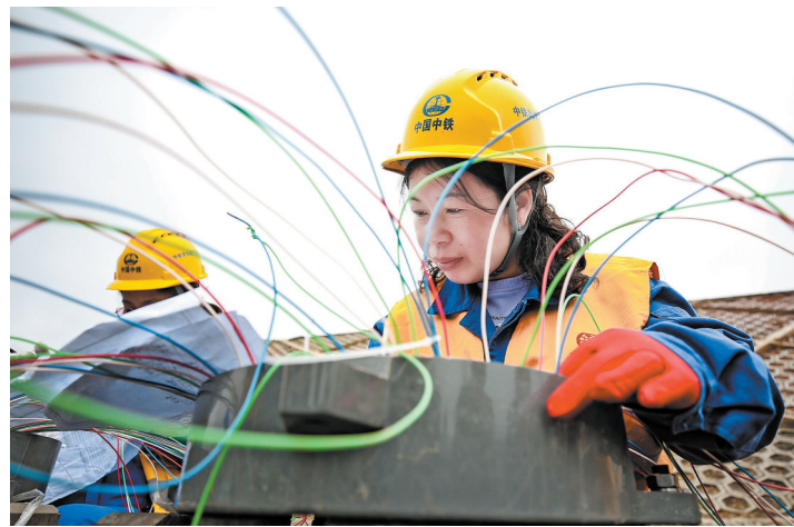
突击队员余静在进行方向盒配线作业。
