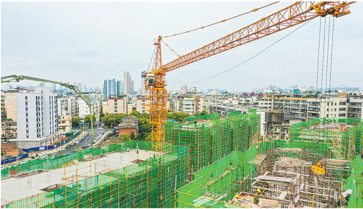
日前，在章贡区桔红T街城市棚户区改造安置房工程项目施工现场，施工人员在加快工程项目建设。章贡区加快棚户区安置房建设步伐，积极完善安置房周边交通道路、污水与垃圾处理等基础设施项目，有效保障了群众住有所居、居有所安。 胡江涛 摄
