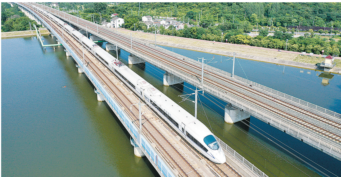
一列和谐号动车组列车驶经京沪高速铁路南京段。(2020年6月30日摄) 新华社发(方东旭 摄)
