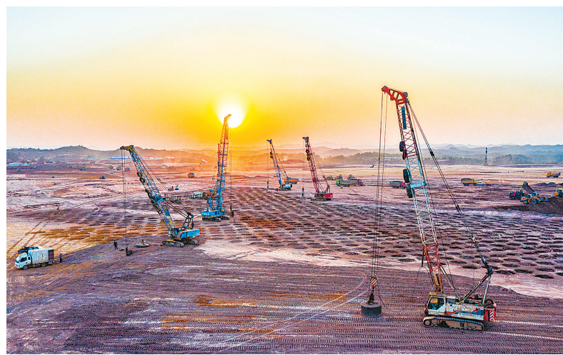
建设中的南康区格力电器智能制造基地。郭先明 摄
