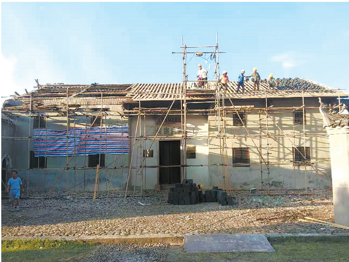
修缮中的小布中共苏区中央局旧址。
