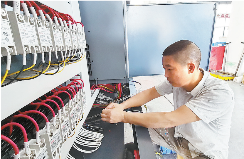
工人在江西众锐机械制造有限公司内组装总控箱。
