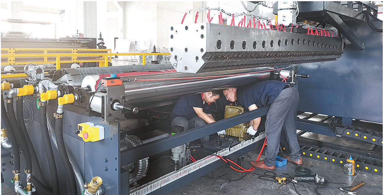
寻乌产业孵化示范基地内企业工人在组装设备。
