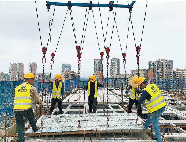
江南府施工现场。
