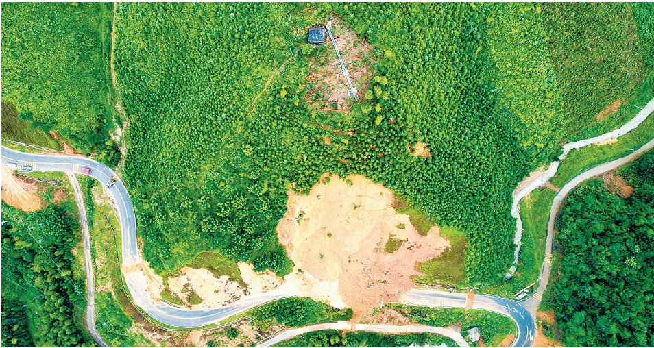
在过埠—上堡旅游公路,部分地段出现山体滑坡。
