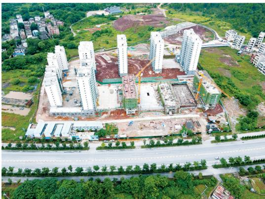
←图为瑞金市黄柏水口安置房项目。据悉,该项目总投资4.35亿元,分两期建设,项目一期建设包括10栋545套安置房及幼儿园,目前,已有7栋房屋完成主体结构施工及外墙粉刷,正实施内部装修及电梯安装;剩余3栋房屋正进行主体结构施工,完成工程量的50%,计划今年年底完成主体封顶,项目一期预计明年6月竣工验收并交付使用。刘海燕 杨旭 摄
