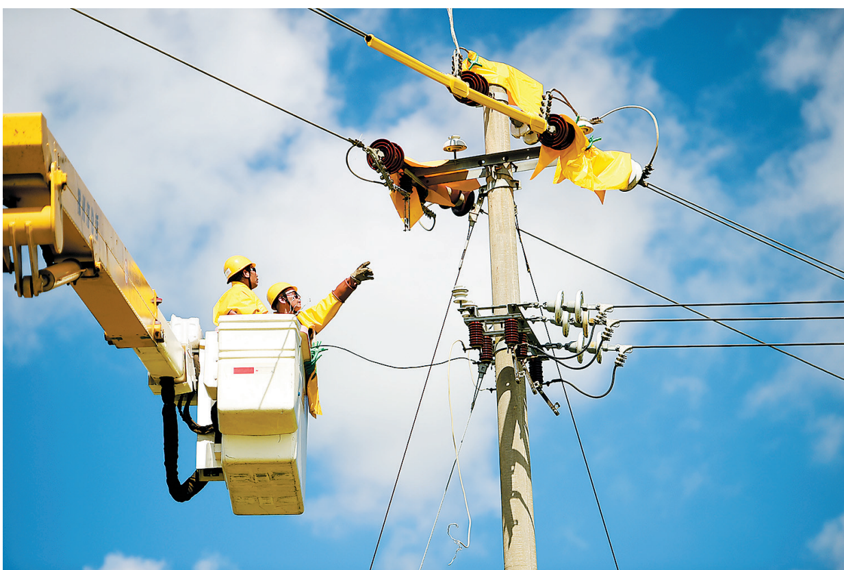
日前,供电施工人员在烈日下抢修会昌县文武坝镇的电力故障。进入夏季以来,国网会昌县供电公司启动高温保电应急预案,全面加强重点电网设备特巡、夜巡,进一步排查设备隐患,并通过带电作业、线路综合检修等方式,全力保障电网安全稳定运行,保障居民迎峰度夏。 吕春华 邹丽摄
