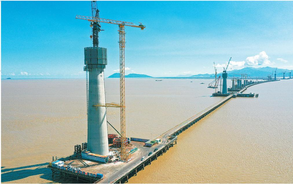
建设中的黄茅海跨海通道高栏港大桥东主塔(前)(无人机照片,7月12日摄)。目前,黄茅海跨海通道高栏港大桥建设进展顺利,大桥东主塔已完成15个节段约87米高度的建设。高栏港大桥连接从港珠澳大桥连接线引出的鹤港高速,西接黄茅海大桥,是黄茅海跨海通道的组成部分。新华社记者刘大伟 摄
