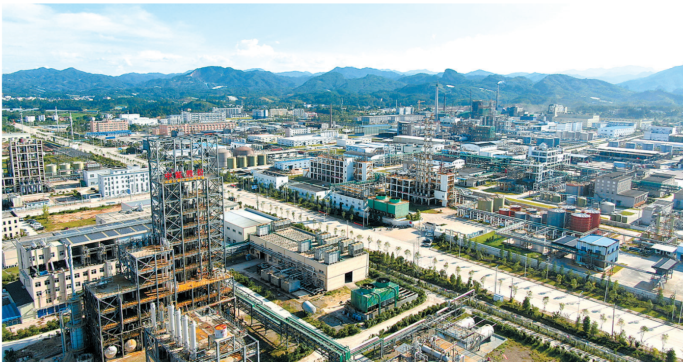
图为航拍的会昌氟盐新材料产业基地。
