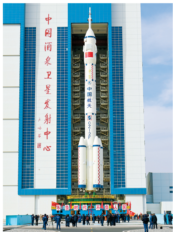
11月21日,神舟十五号载人飞船与长征二号F遥十五运载火箭组合体准备转往发射区。新华社发(汪江波摄)
