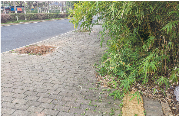
五洲大道被竹林“吞没”的盲道仍未处理。
