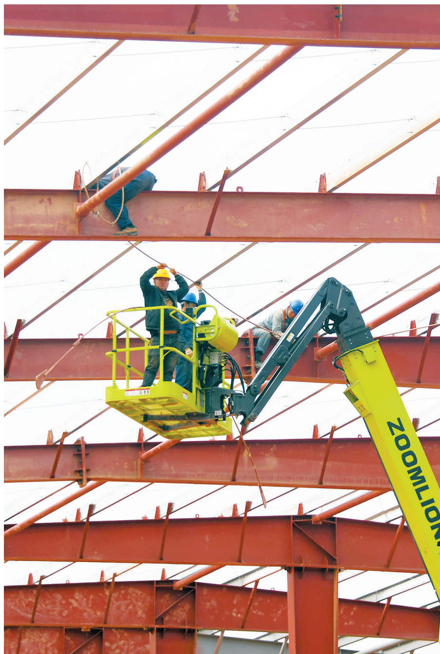
2月17日,位于定南县工业园区的赣州龙凯科技有限公司年处理8万吨废旧锂电池梯次再生利用项目建设现场,工人正在抢抓工期赶进度。 特约记者詹继成 摄
