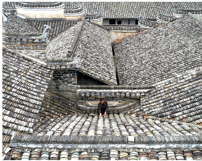
赣南客家围屋营造技艺省级传承人李明华在检修乌石围瓦面。
