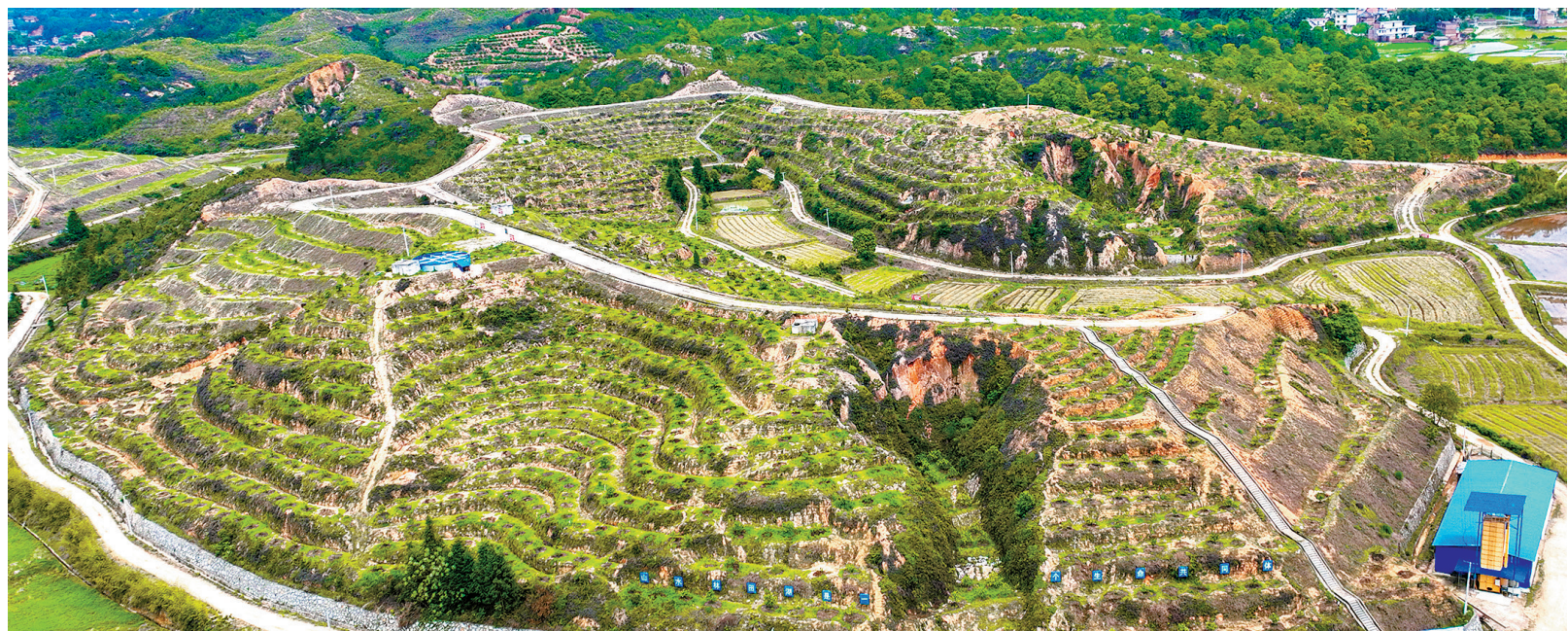
4月25日,兴国县永丰镇凌源村崩岗治理点——虎形山上橙花飘香,生机盎然。当地采取“山上戴帽、山腰种果、山下穿靴”的方法,将这片昔日的崩岗地变成“花果山”。2017年以来,通过赣州市山水林田湖草综合治理项目,兴国县共治理了2003处崩岗,32.3平方公里的土地重获新生,成为南方地区崩岗治理示范样板之一。
