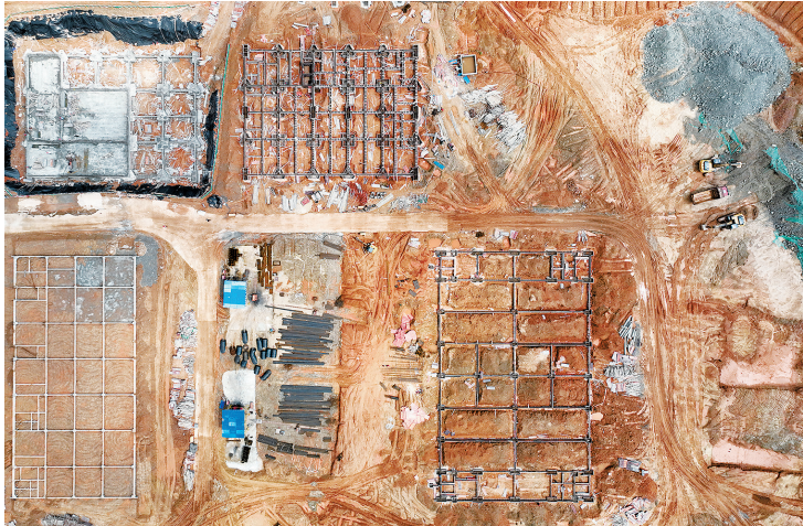
石城县城北仓储物流园建设项目现场。
