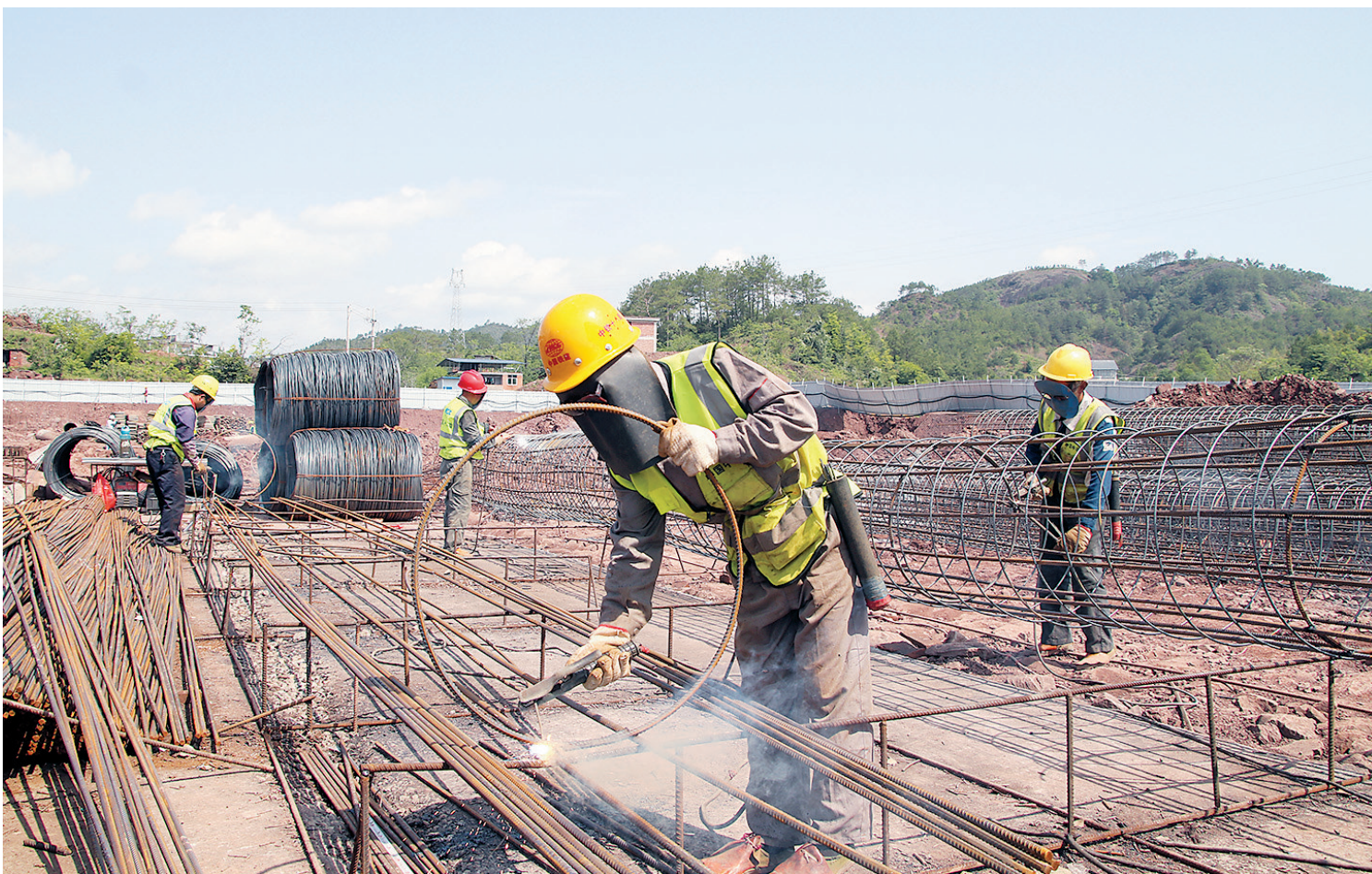
重点项目加紧建设中。
