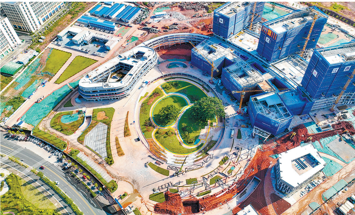
7月2日，建设者们在广东省人民医院赣州医院（沙河院区）项目施工现场作业。连日来，施工单位趁着天气晴好，抓紧施工作业，确保项目早日建成投用。项目建成投用后，将为赣南地区及赣粤闽湘四省毗邻区域群众提供更好的就医环境，大幅提升公共救治能力。
