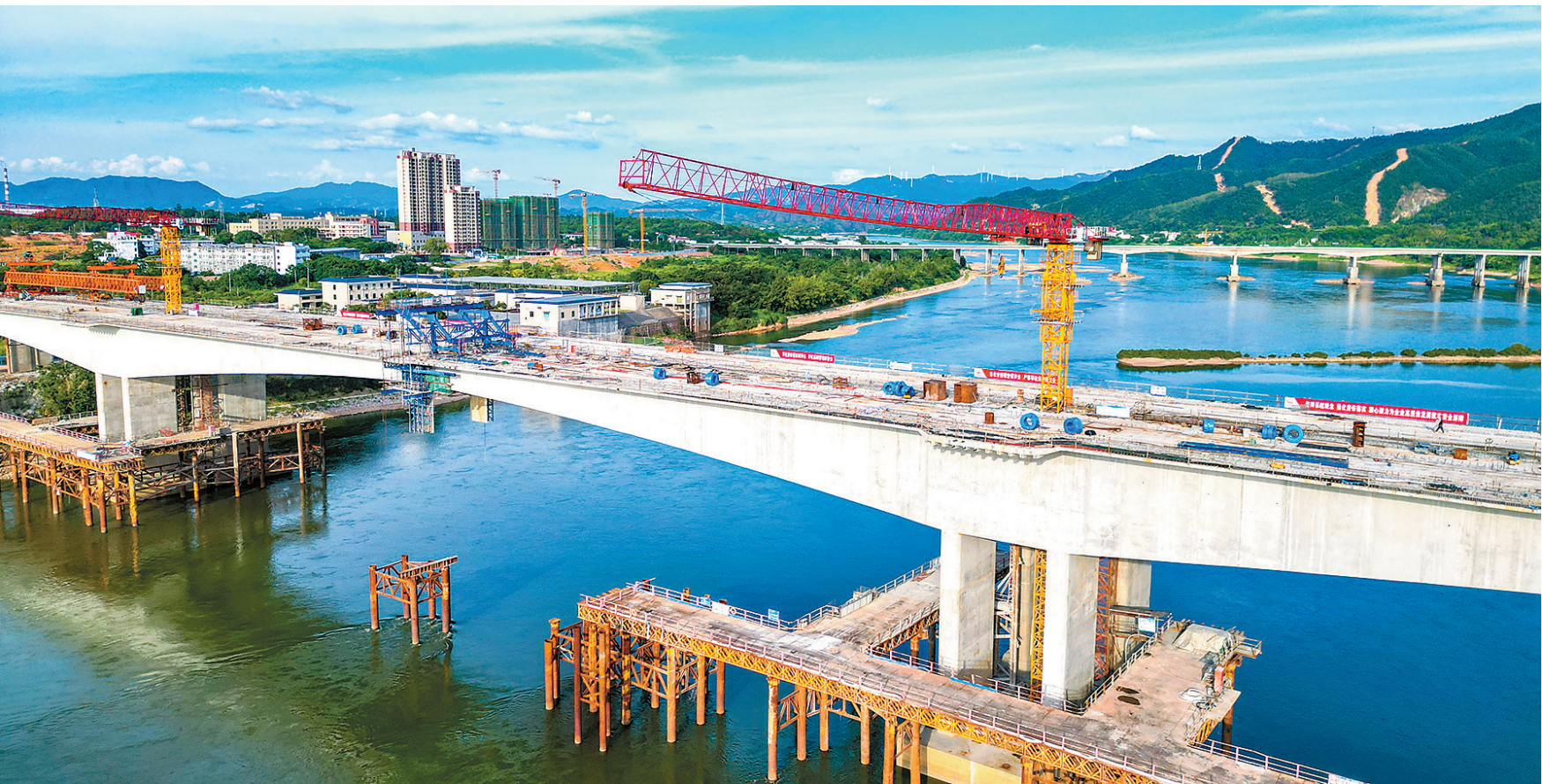
7月3日,赣县区汶潭大桥项目施工现场,工人们正在进行主桥合龙前的收尾工作。汶潭大桥主桥长约606米,位于赣县区义源新区与洋塘片区之间,该桥建成后将成为沟通两个片区的重要通道。
