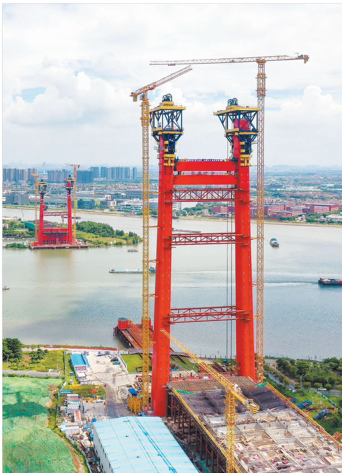
建设中的顺德大桥双塔(无人机照片,8月4日摄)。
