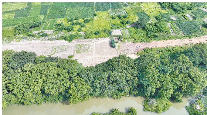
江西省五河治理防洪工程宁都县城防洪堤赤坎区段项目。
