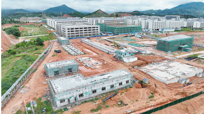
安远县永镇水厂建设工程。
