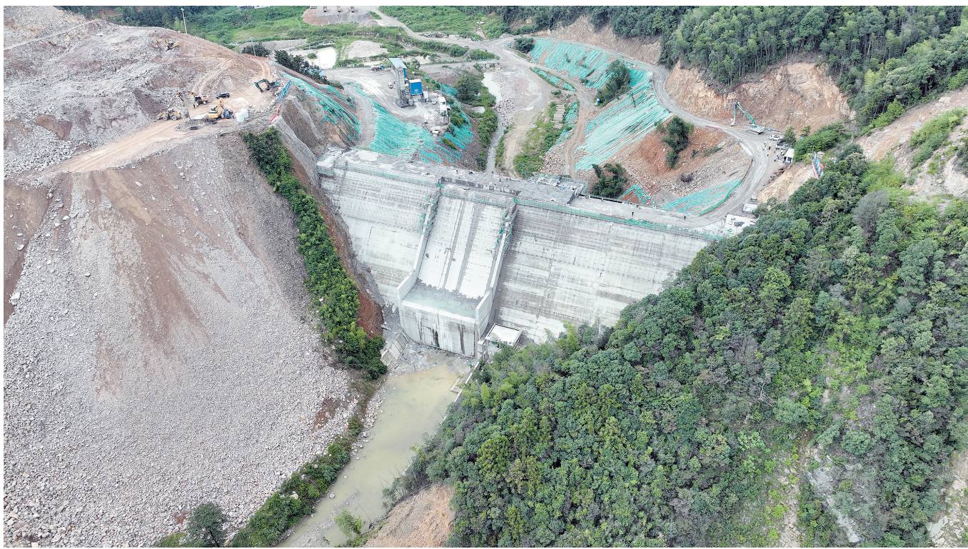
于都县岭下水库应急水源工程。
