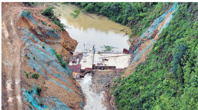
赣县野猪坑水库项目。
