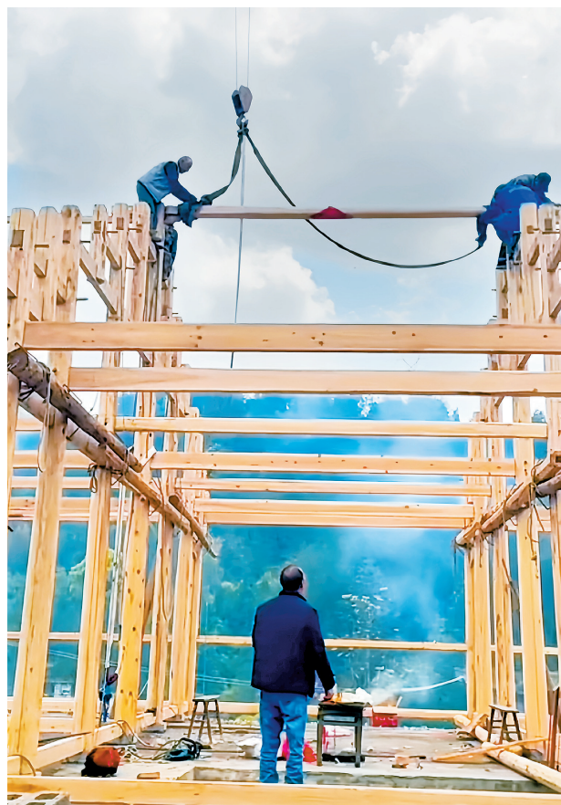
南康木匠在安放祠堂大梁。
