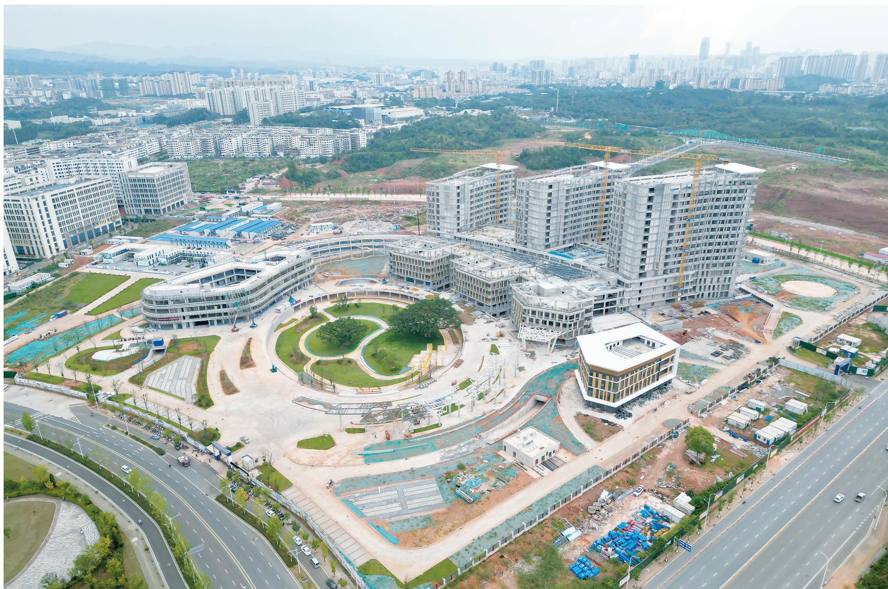
正在加速建设的国家区域医疗中心——赣州市立医院(广东省人民医院赣州医院)。目前,该项目主体结构施工已完工,进入装饰装修施工阶段。
