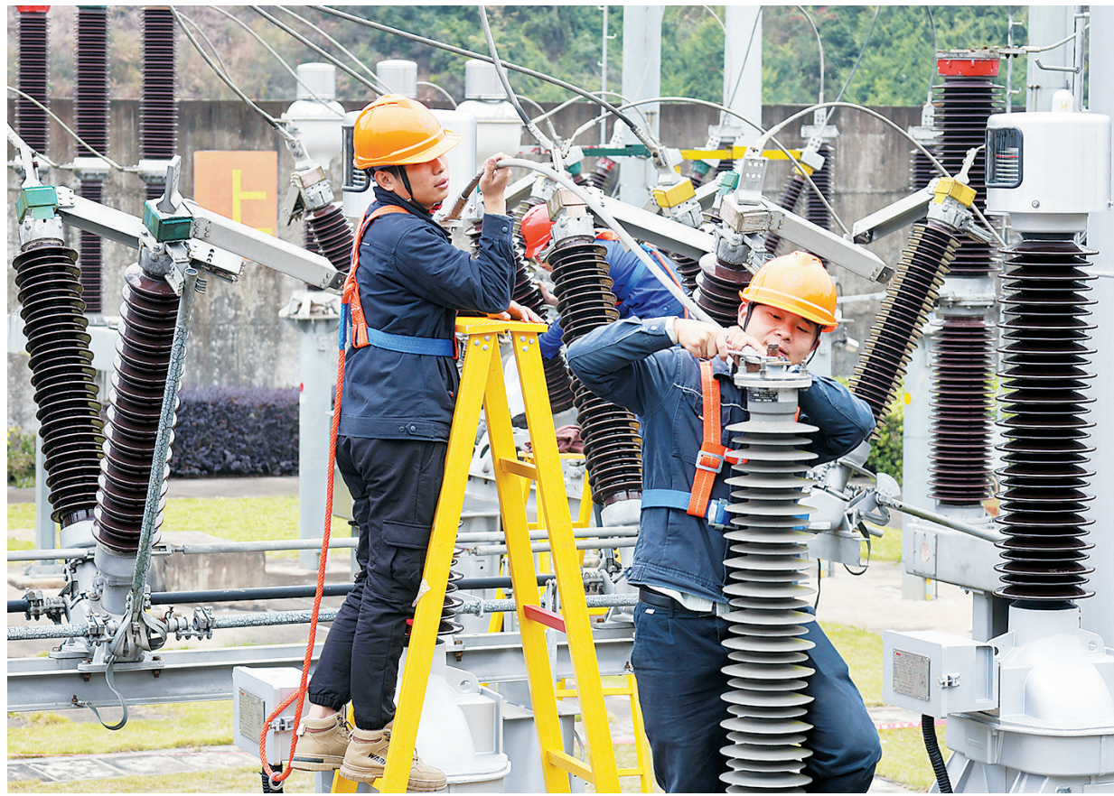
近日,电力检修人员对110千伏电压互感器进行技术改造。近期寒潮来袭,江西赣能股份有限公司居龙潭水电厂迎寒而上,及时完成两台机组检修、110千伏电压、电流互感器技术改造工作,为落实“保供电”打下坚实基础。 记者邹志辉 通讯员吴书梅 摄
