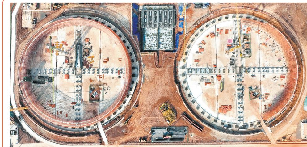
2月13日,位于信丰县的陝投信丰能源2x1000MW机组扩建工程(信丰电厂二期项目)建设现场,塔吊林立,工人紧张有序地施工作业,呈现出节后复工开局争先、起步提速的火热状态。目前,项目场平工程全部完工,土建、桩机等基础工作完成85%以上,冷却塔开始环形基础施工。该项目计划明年8月首台机组投产。
