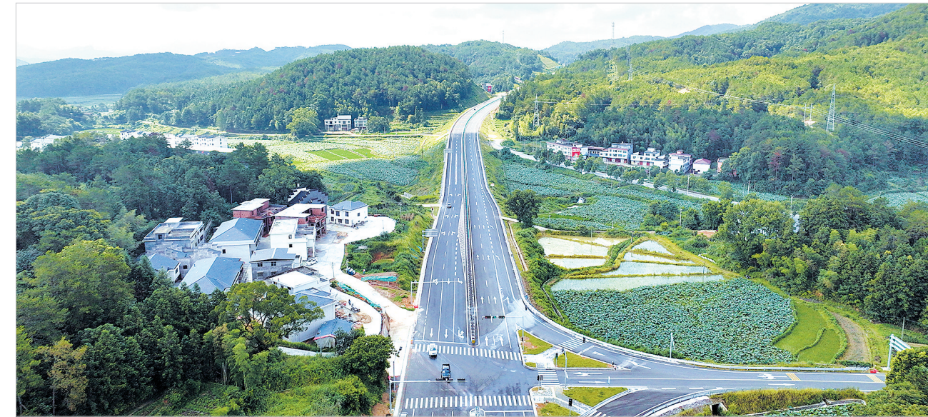
8月1日，206国道石城段改扩建工程全线贯通，一辆辆汽车在公路上来往穿梭，与蜿蜒的公路、错落有致的民居相映成趣，构成一幅美丽的乡村画卷。
