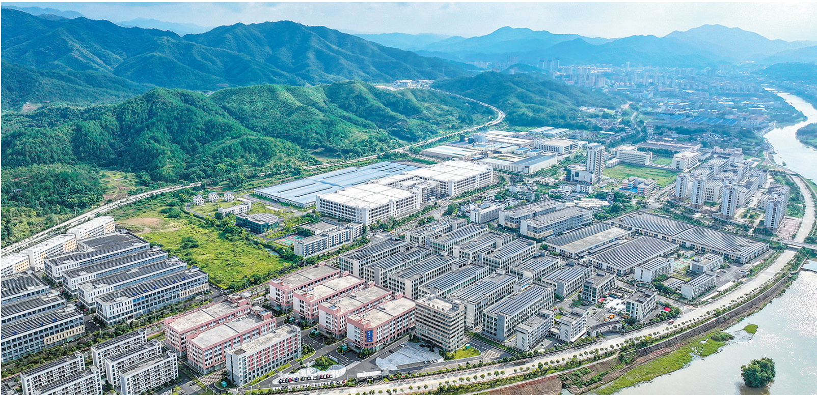
航拍下的全南县电子信息产业园全景。近年来,全南县大力推动形成“一群多链、聚链成群”的发展格局,推进5G智能产业园建设,吸引了众多科技型企业入驻园区。截至目前,全南县电子信息产业企业数量已超100家,形成了完整的光电显示产业链条。
