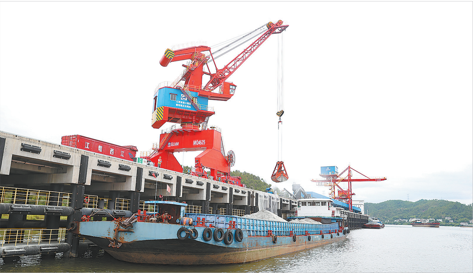
8月5日，赣州港五云码头，工人操作着吊机装卸货物。赣州港五云作业区综合枢纽码头位于赣县区五云镇赣江左岸，现建有5个1000吨级泊位，含3个多用途泊位、2个散货泊位，今年1月至7月已完成货物吞吐量10.1万吨。
