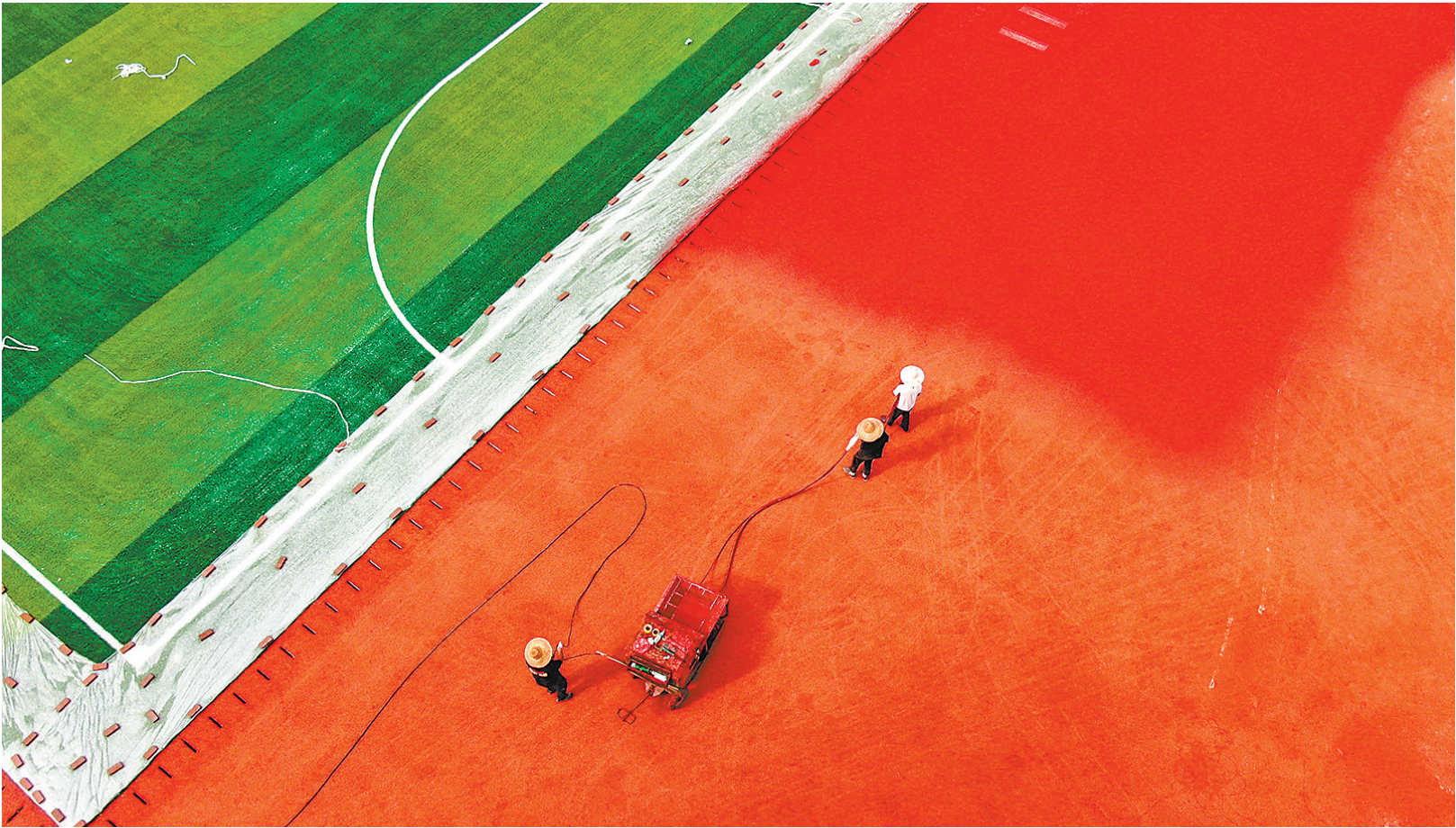
8月22日，会昌县第六小学项目新校区建设现场，工人在严格按照环保标准对操场进行塑胶铺设作业。该项目系会昌县重点民生工程之一，总投资约6500万元，建筑面积1.8万多平方米，主要涵盖教学楼、综合楼、运动场及基础配套设施。项目建成后，将大幅提升区域基础教育服务能级，让更多孩子在家门口就能享受到优质教育。 特约记者 刘兆春 摄
