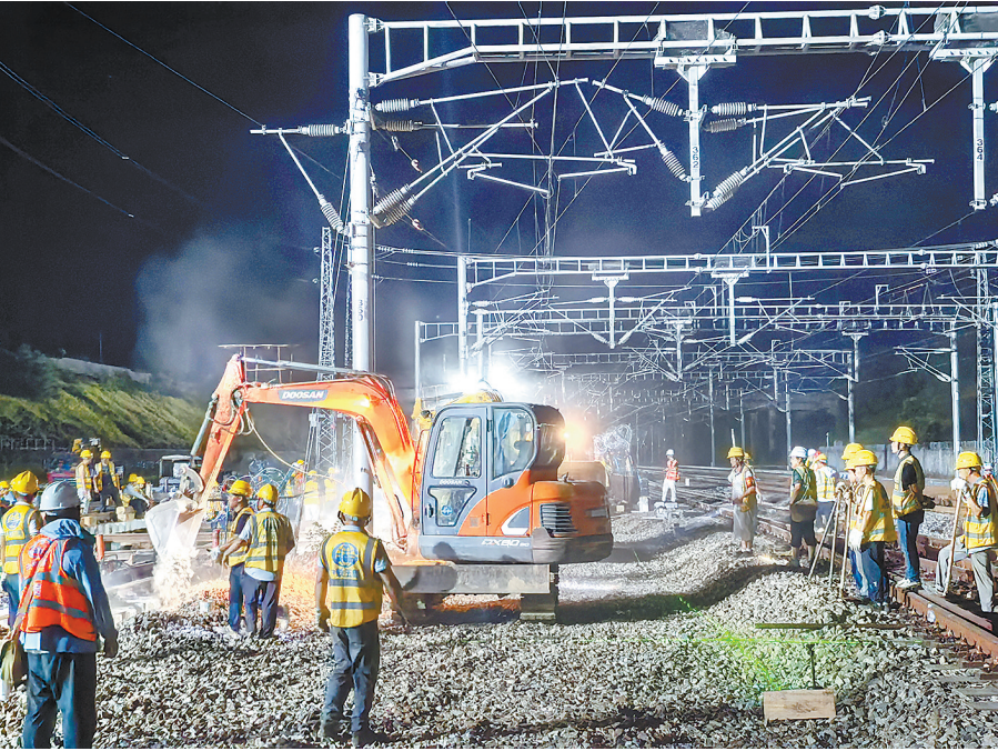
8月15日凌晨,在瑞梅铁路瑞金站改道铺道岔施工现场,中铁五局的近200名施工人员挑灯夜战,历经230分钟的连续作业,成功将一组P60—9#道岔铺设在江西瑞金站指定位置,安全、正点开通线路。图为施工人员正在开展道床平整作业。 栗荣富 摄
