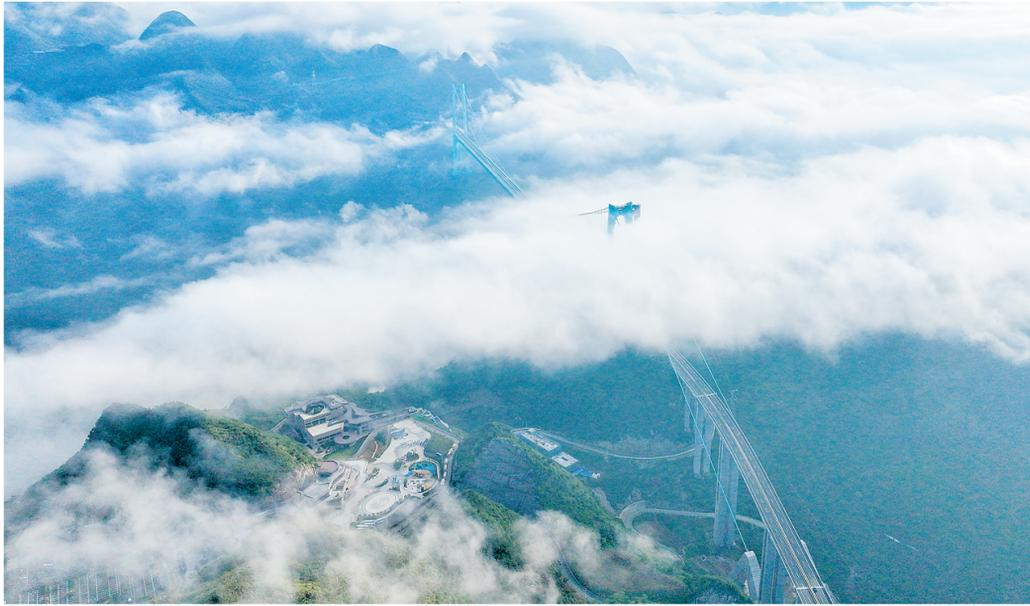
9月28日拍摄的贵州花江峡谷大桥（无人机照片）。9月28日，世界第一高桥——贵州花江峡谷大桥建成通车。花江峡谷大桥是贵州六枝至安龙高速公路的控制性工程，大桥全长2890米，主跨径1420米，是目前世界山区峡谷第一大跨度钢桁梁悬索桥；其桥面距水面垂直高度625米，高度超过北盘江第一桥近60米，是新的世界第一高桥。
