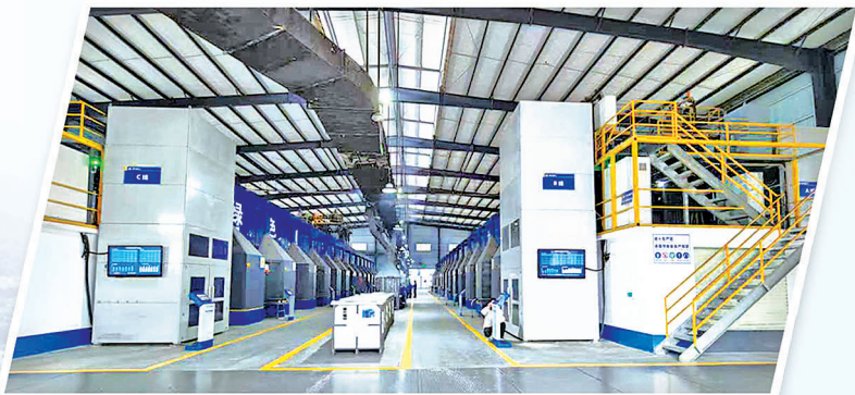
赣州晨光稀土新材料有限公司生产车间。
