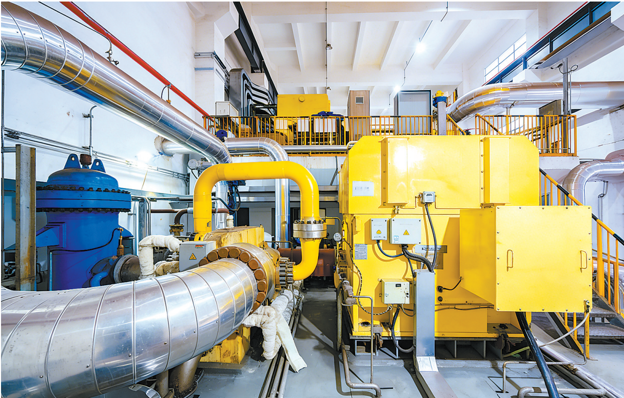
这是“超碳一号”的压气机及电动机(资料照片)。12月20日,全球首台商用超临界二氧化碳发电机组在贵州六盘水首钢水钢集团成功商运,这也是超临界二氧化碳余热发电技术“超碳一号”的全球示范工程。
