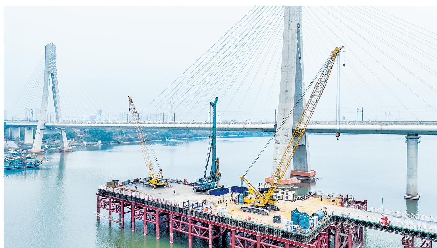
12月22日，新建长赣高铁江西段赣州赣江特大桥首桩顺利实现开钻，标志着该桥正式开工建设。大桥全长2079.02米，其中主桥长572.1米，最大跨度达300米，是长赣高铁江西段最大跨度桥梁，也是全线关键控制性工程。长赣高铁设计时速350公里，是国家“八纵八横”高速铁路网渝长厦通道的重要组成部分，也是国家“十四五”铁路发展规划的重点建设项目。
