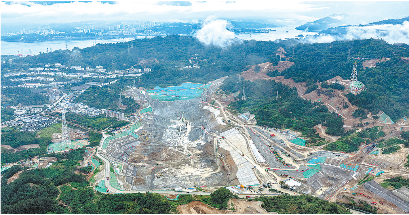
9月30日拍摄的三峡枢纽新通道先行开挖区项目施工现场(无人机照片)。9月30日18时许,三峡库首西陵峡北岸,随着最后一炮爆破,三峡枢纽新通道先行开挖区项目顺利完成全部爆破开挖作业。这一项目是三峡水运新通道的施工准备试验工程,其顺利完工将为后续高压输电线路迁改、船闸主体工程全面施工创造有利条件,同时也标志着三峡水运新通道工程即将迈入全面施工的新阶段。 新华社记者肖艺九 摄
