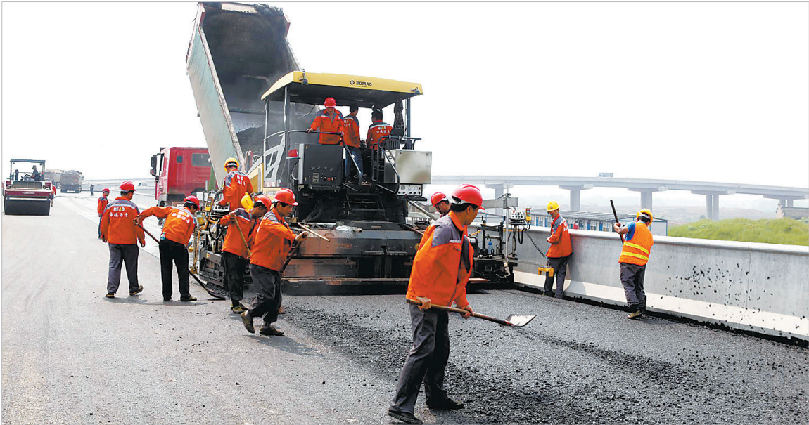
4月24日,在客家大道西延(高架段)高架主线和地面道路施工现场,项目施工方正抢抓停雨间隙抓紧施工,为7月底的道路全线通行积极奋战。该项目是赣州高铁新区核心区首个开工的道路项目,也是首个高架主线与地面同时摊铺沥青的项目。施工方入场以来,积极开展质量创优活动,项目成功创评江西省、赣州市建筑结构示范工程。
