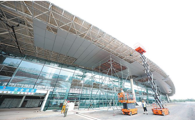
赣州黄金机场T2航站楼主体已基本完工,不断完善的综合立体交通,让赣州真正地“飞起来了”。
