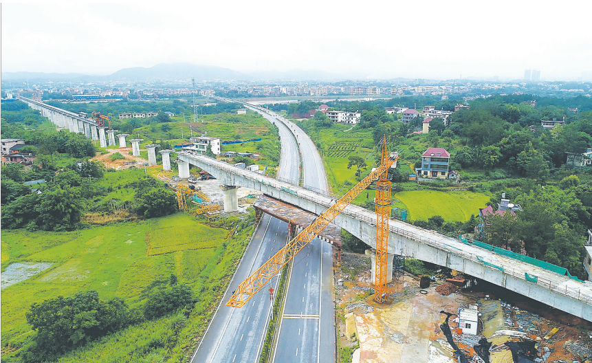
建设中的兴泉铁路兴国平江大桥。兴泉铁路通车后,宁都、石城将告别无铁路通行的历史。
