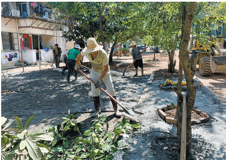
7月27日,工作人员在铁路生活二区硬化路面。连日来,章贡区创国卫办联合铁路周边相关部门,对赣州火车站及周边老旧小区、机关单位存在的环境卫生问题,分门别类进行排查及整治。 程舒 记者吴悦 摄
