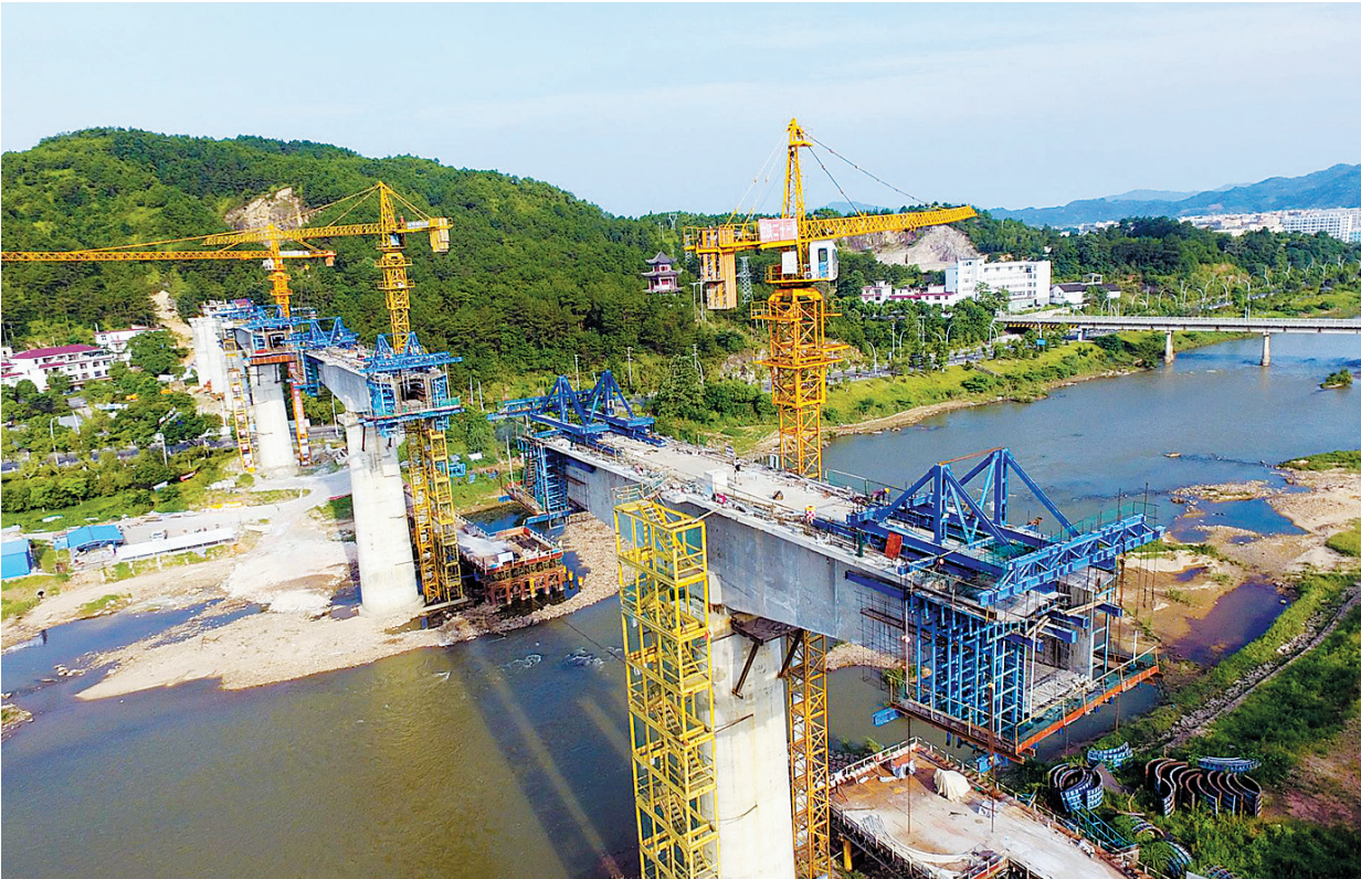
图为7月28日记者航拍的兴泉铁路石城琴江特大桥施工现场。目前,该铁路全线各标段建设进展顺利,已进入“大干一百天”夏季攻坚阶段。兴泉铁路起于江西兴国,止于福建泉州,是国家一级铁路,设计时速160公里,建成后将结束石城、宁都不通铁路的历史,有望在2021年年底通车试运营。 温京燕 记者陈地长 摄
