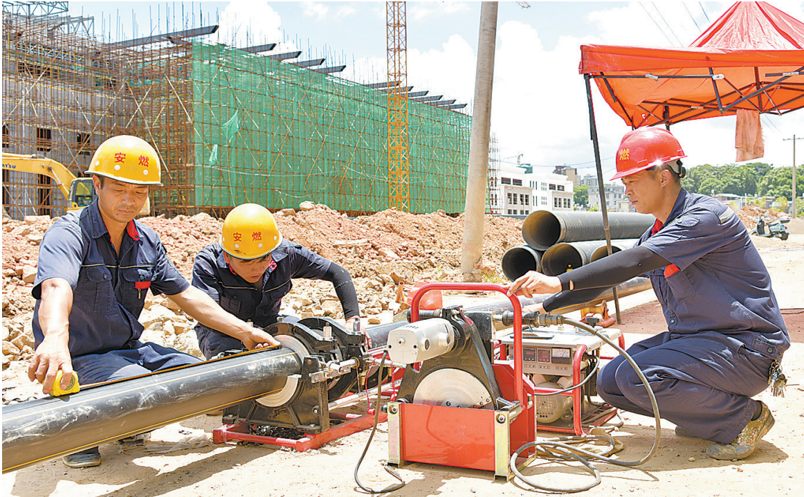
7月24日，在安远县二级综合客运站施工现场，施工人員顶着烈日安装天然气管道。连日来，安远县持续经受36℃以上高温“烤”验。为确保该县二级综合客运站工程如期完工，施工人員顶着烈日作业，施工单位采取调整工人作息时间，普及防暑知识，赠送绿豆汤等措施，避免工人施工期间中暑。
