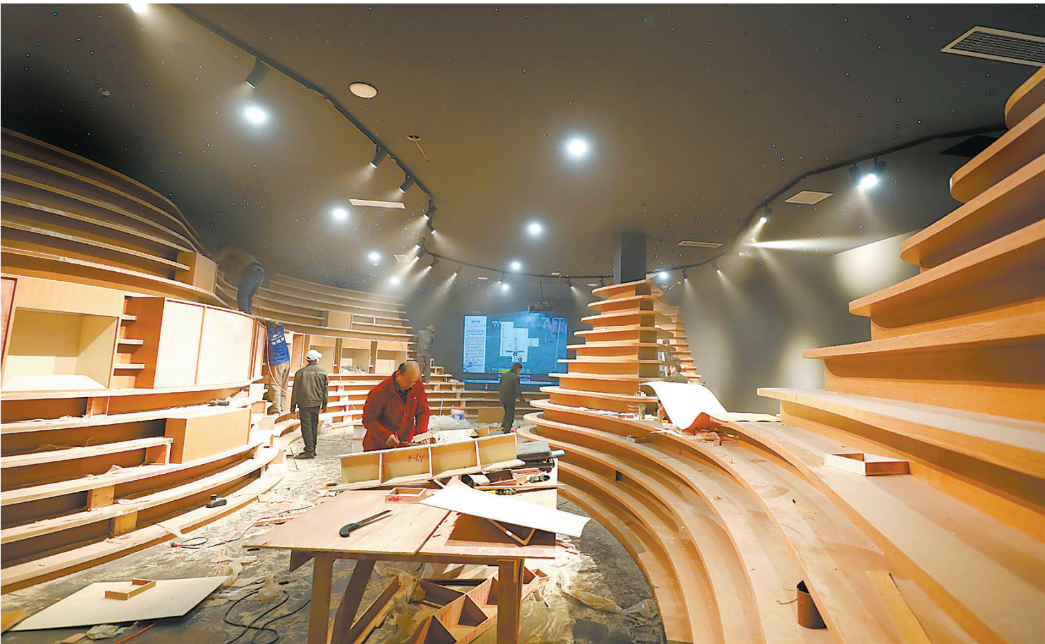
十二月二十五日,工人在赣州福寿沟博物馆加紧施工。福寿沟博物馆及魏家大院修缮项目位于赣州市海会路以东、厚德路以北,目前已进入施工收尾阶段。福寿沟博物馆展馆采用福寿沟水流造型,体现了雅致的建筑风格,与相邻的魏家大院清代院落相得益彰。记者吴悦摄
