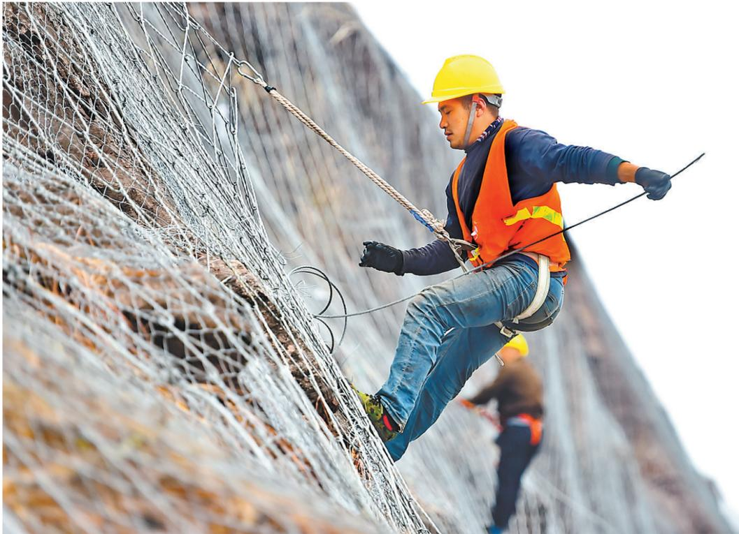
12月24日,会昌县站塘乡206国道横岭村黄牛湾路段,工人给受风化的崖壁安装钢丝防护网。该县还通过基坑支护、喷浆复绿等生态防护措施,对极易发生山体滑坡的地带全面加固治理,构建安全畅通的交通出行环境。
