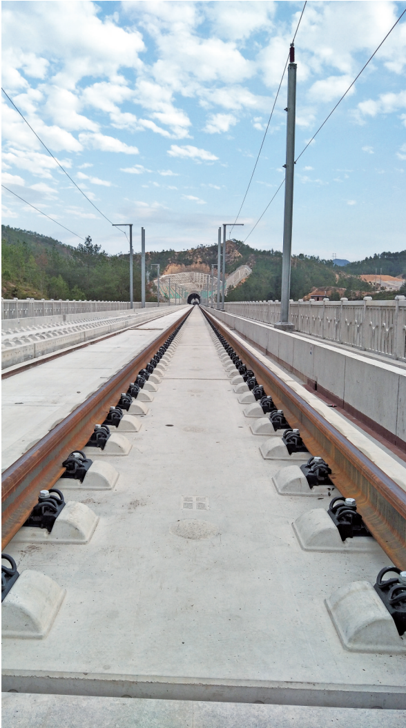
▲铺设好的铁轨。
