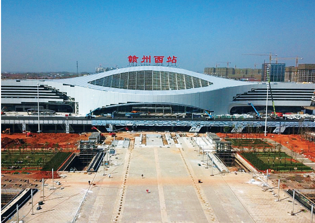
▲施工中的赣州西站。
