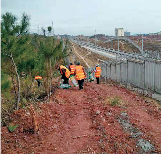
▲整治高铁沿线环境卫生。
